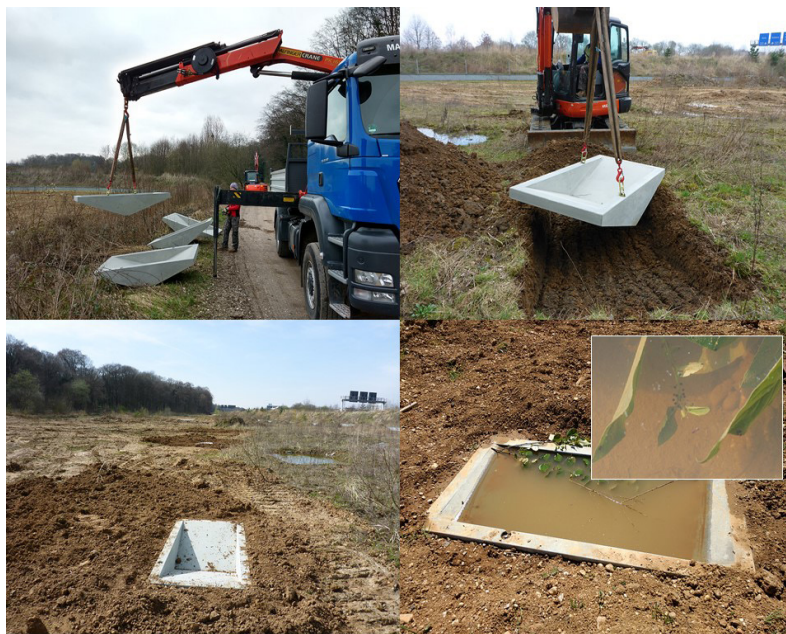
(Fig. 23.) Installazione di cinque bacini di cemento per l'ululone dal ventre giallo in Germania (Biologische Station Bonn / Rhein-Erft e.V.; immagini di proprietà NABU – Naturschutz Deutschland).
